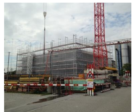
Erstellung der Energiezentrale Torfeld.
