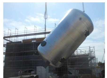
Einbringung des technischen Speichers für die Kälte (2 x 64 m 3 ) in die Energiezentrale Torfeld.
