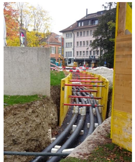
Bau der Wärme- und Kälteleitungen durch den Kasinopark, Aarau.
