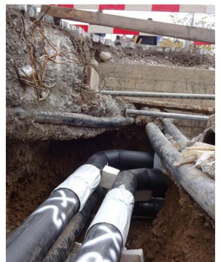
Rohrleitungsbau im städtischen Umfeld ist immer mit Werkleitungsproblemen verbunden.
