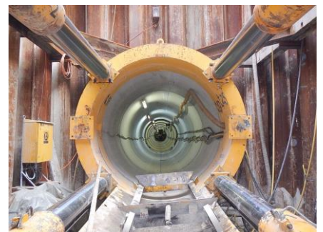
Unterstossung der SBB-Geleise Zürich-Bern mit Integration weiterer Medien.
