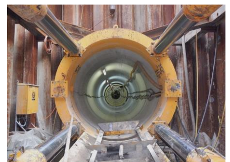
Unterstossung der SBB-Geleise mit einem Innendurchmesser von 2.50 m.
