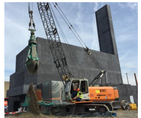
Erstellung Rückgabebrunnen neben der Energiezentrale Torfeld.
